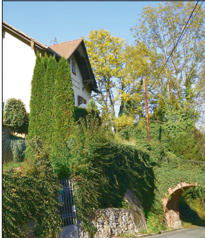
Der „Sophienhof“ (links) wird abgerissen, die Anrainer hoffen aber auf Erhalt der Brücke (rechts), eines Unikats in Graz.
