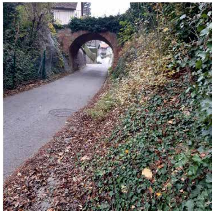
Das kleine Brückerl über den Gritzenweg bestimmt den Charakter des Gritzenweges wie kaum ein anderes Bauwerk.
