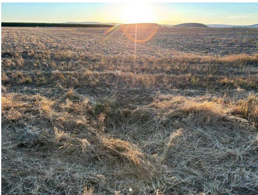
Senke durch möglichen Baueinbruch infolge schweren Geräts
