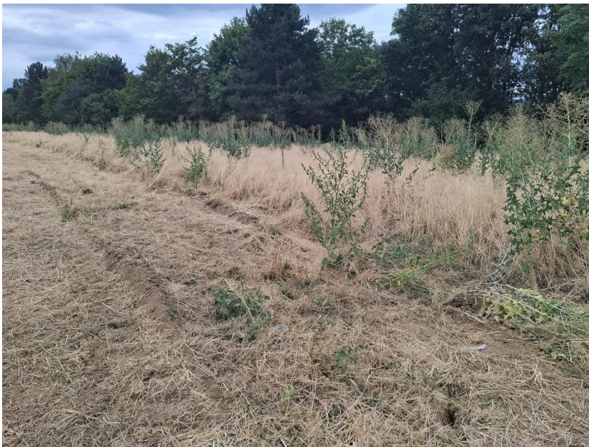
Senke durch möglichen Baueinbruch infolge schweren Geräts
