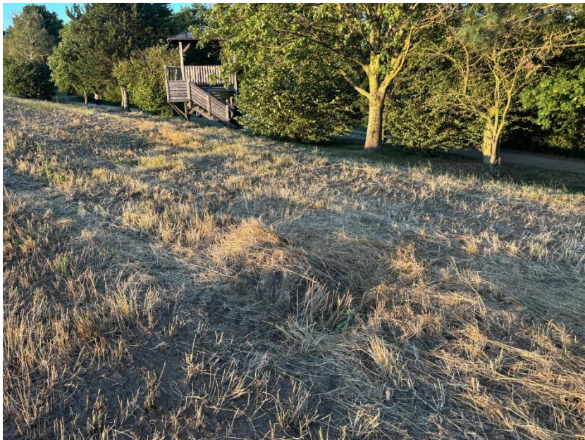
Senke durch möglichen Baueinbruch infolge schweren Geräts
