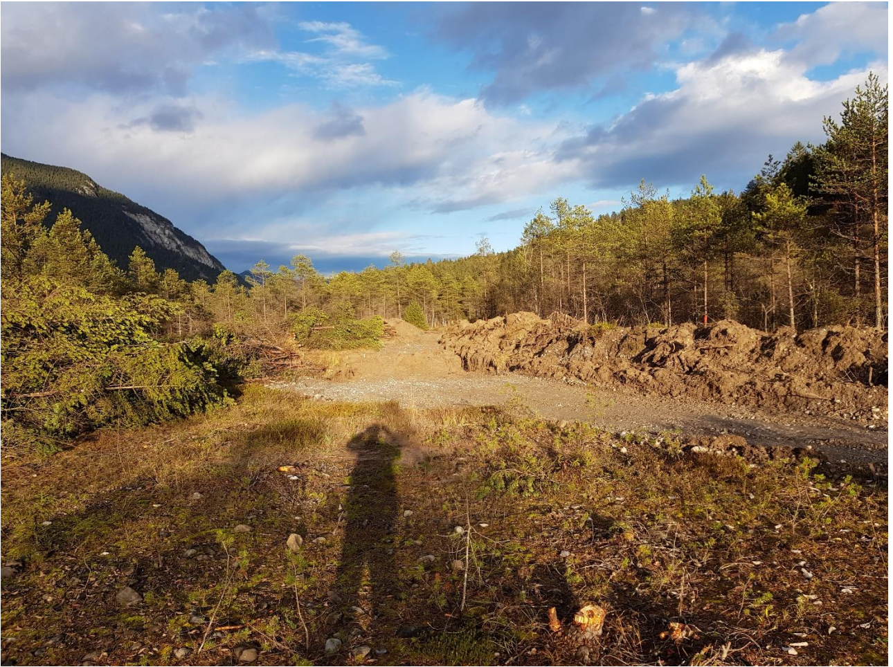
Bachbett: Der Oberboden wird abgetragen (04.11.2019)
