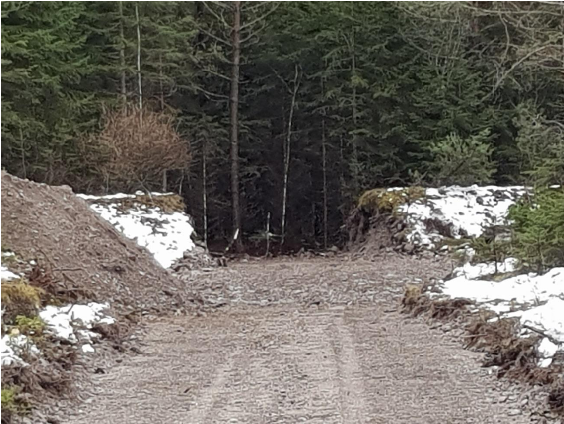
Buhne West: Hier entsteht der neue Buhnenkopf (23.11.2019)
