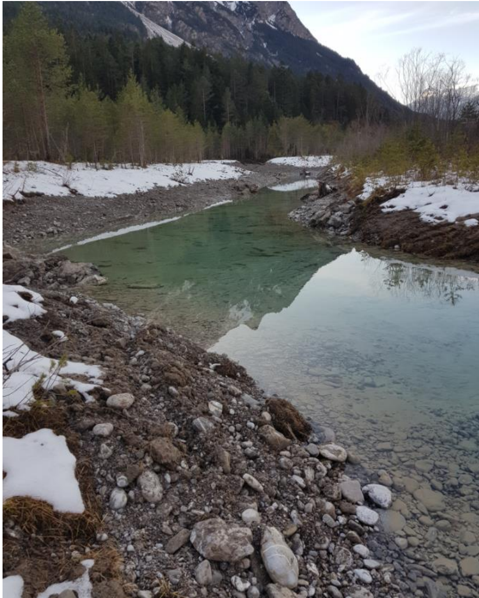
Fertiggestellter neuer Bachlauf: östliches Ende – Blickrichtung Westen (19.12.2019)
