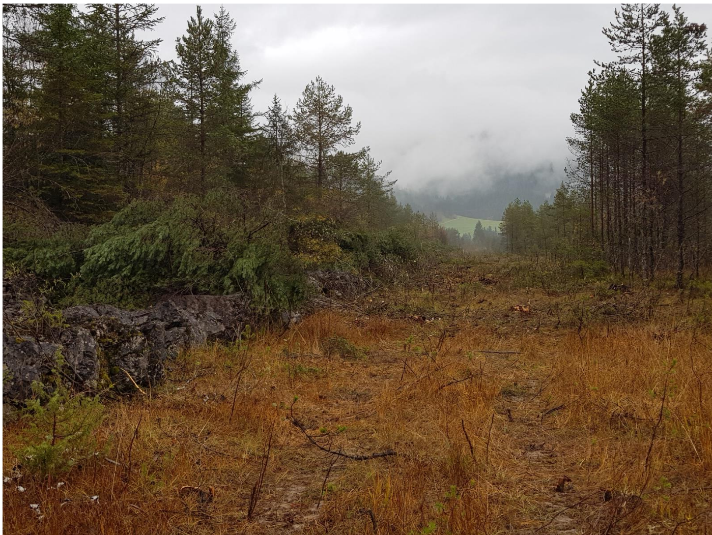
Rodungsarbeiten an der Buhne Ost (28.10.2019)
