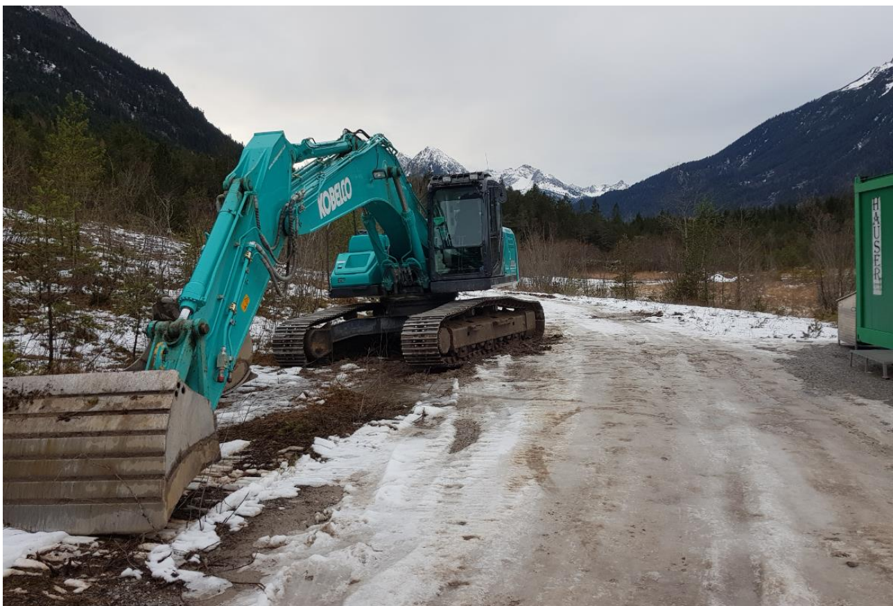
Die Bagger sind eingetroffen
