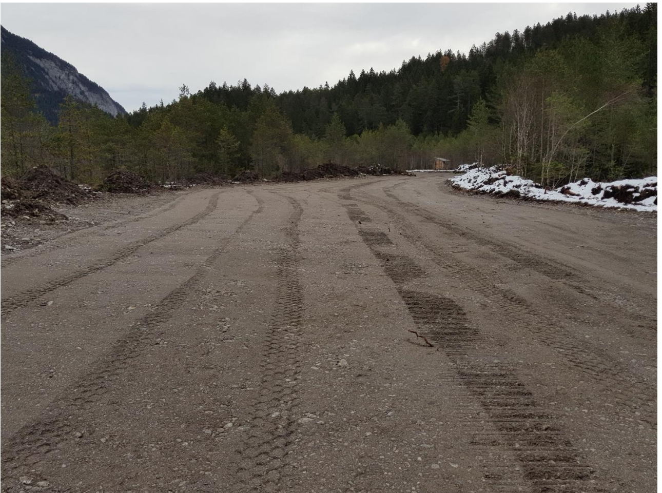
Bachbett: Der Oberboden ist abgetragen (23.11.2019)
