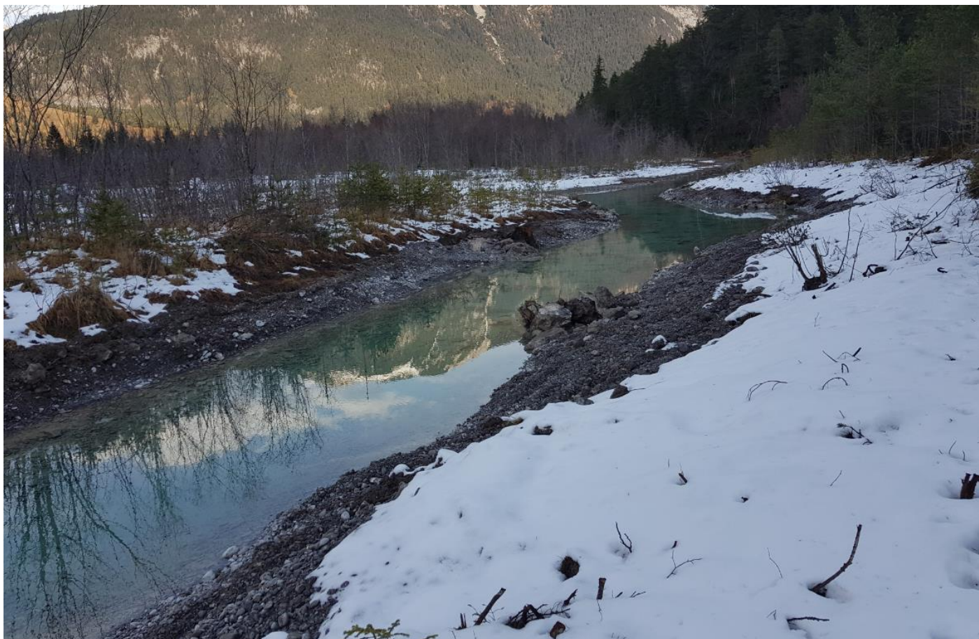
Fertiggestellter neuer Bachlauf: östliches Ende – Blickrichtung Osten (19.12.2019)
