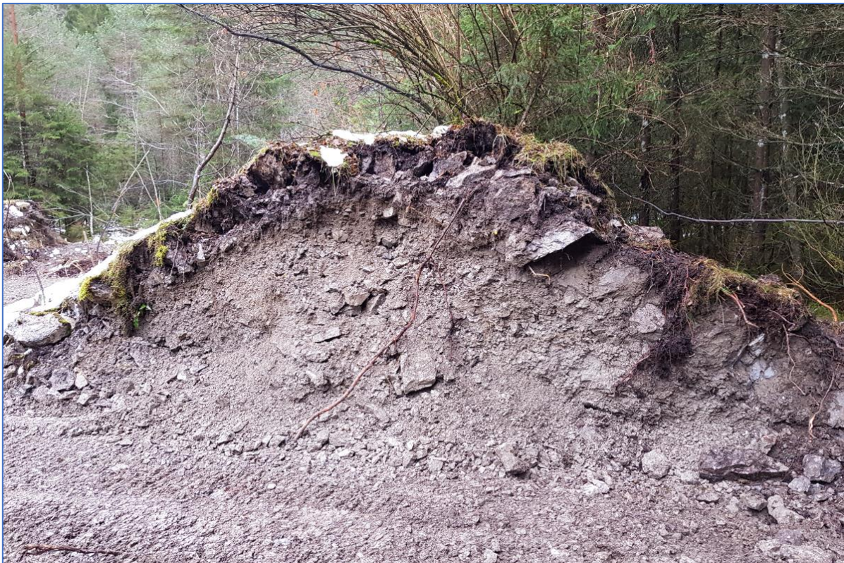
Buhne West – Öffnung im Bereich des künftigen Buhnenkopfes: Der Kern der Buhne besteht aus Schotter
