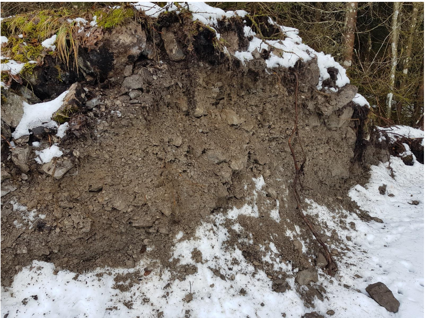
Buhne West – Öffnung im Bereich des künftigen Buhnenkopfes: Der Kern der Buhne besteht aus Schotter (19.12.2019)
