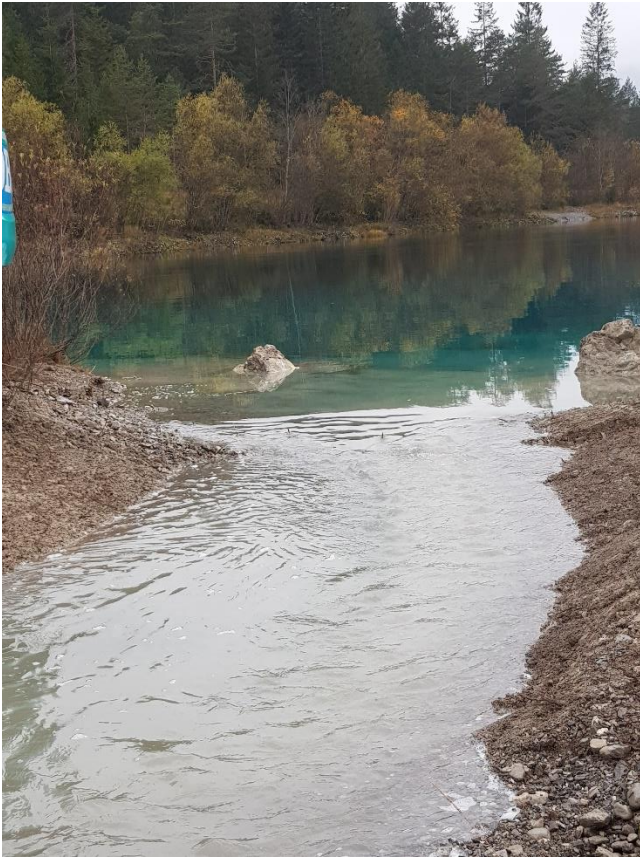
05.11.2020: Seeauslauf (so angelegt, dass der Wasserspiegel bis auf weiteres „nur“ um ca. 15cm fällt)
