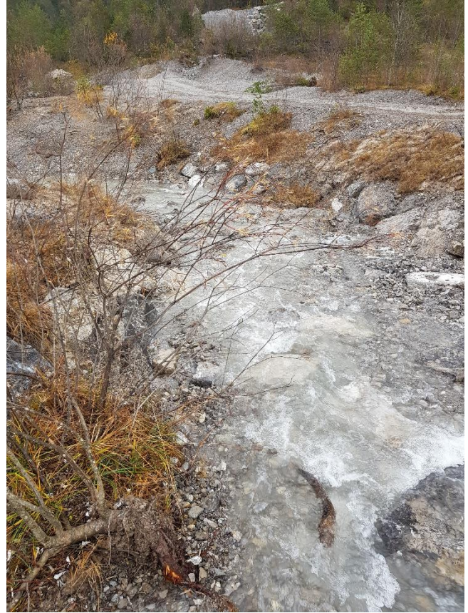
05.11.2020: Seeauslauf (so angelegt, dass der Wasserspiegel bis auf weiteres „nur“ um ca. 15cm fällt)
