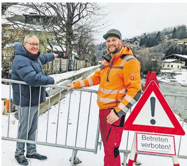
Besichtigung bei der aktuell ruhenden Baustelle im Bereich Stampferau: Bgm. Wolfgang Viertler (l.) mit Herrmann Stöckl. Der Rauriser ist bei der Schutzwasserwirtschaft des Landes tätig. BILD: NOTHDURFNER
